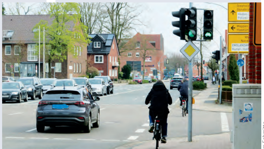
Gefahrenstelle: Rechtsabbiegende Fahrzeuge sind an der Kreuzung Georgstraße/Kaiserstraße für Radler, Fußgänger und Rollstuhlfahrer nicht ungefährlich.
